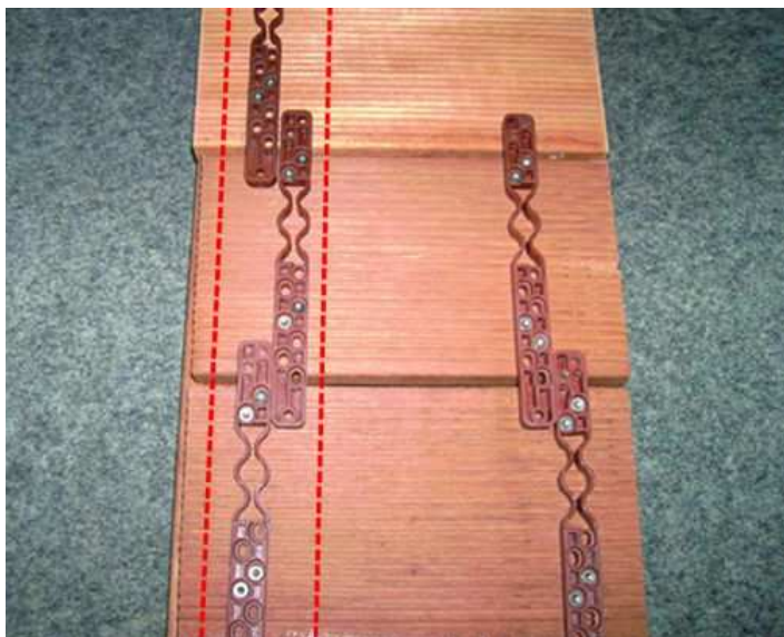
Abb. 6: Die einzelnen Gleiter werden versetzt, auf Höhe der Unterkonstruktion, mit den Dielen verschraubt
