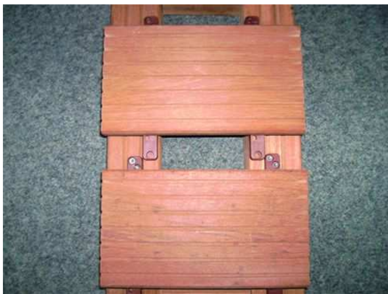
Abb. 4: Die vorbereitete Diele wird unter die vorherige, bereits verschraubte Diele, geschoben.
