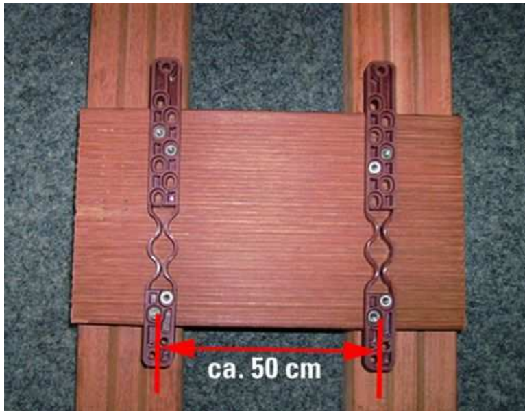
Abb. 3: Der Terrassengleiter wird mit vier Schrauben unter die Diele geschraubt.
