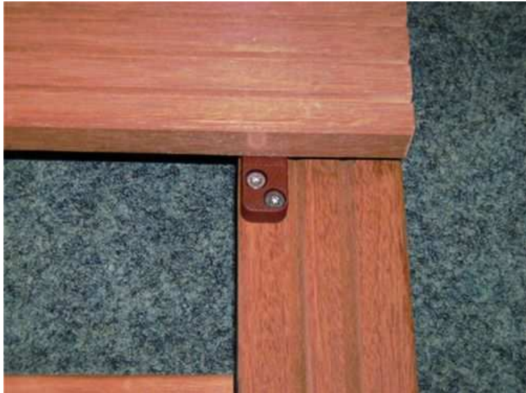
Abb. 5: Der Gleiter wird mit zwei Schrauben mit der Unterkonstruktion verschraubt
