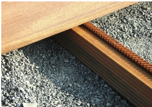
Abb. : 1 beim Terrassenbau wird die Terrassenbauleiste einfach zwischen Diele und Unterkonstruktion verschraubt
