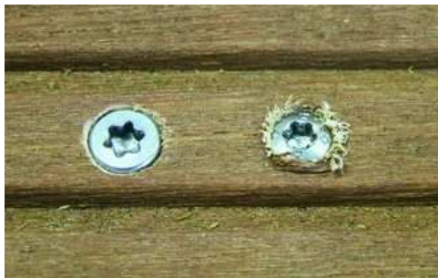
Abb. 6: Links Zylinderkopf der „EASYpat“, rechts konventioneller Senkkopf
