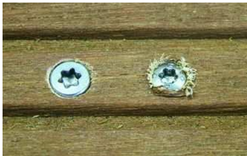
Abb. 6: Links Zylinderkopf der „EASYpat“, rechts konventioneller Senkkopf
