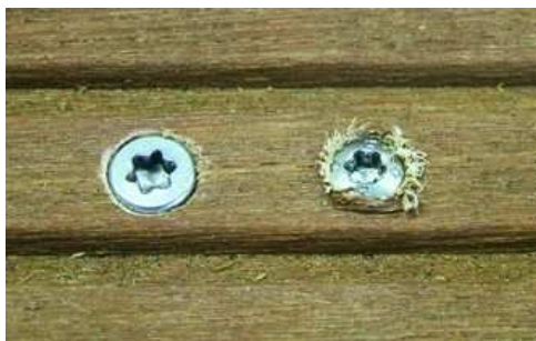
Abb. 6: Links Zylinderkopf der „EASYpat“, rechts konventioneller Senkkopf
